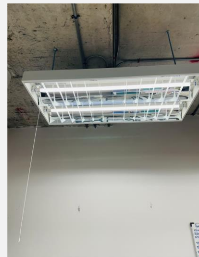
ทุกออฟฟิศมีเช็กรางเพื่อควบคุมการเปิด-ปิดไฟ
