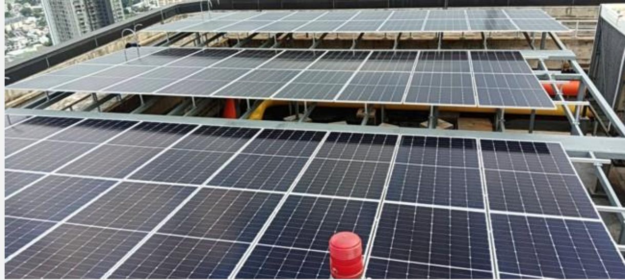
ติดตั้งแผงโซลาร์เซลล์ที่อาคารชาณุอิสสระ ทาวเวอร์ 2 เพื่อนำพลังงานแสงอาทิตย์มาผลิตกระแสไฟฟ้าใช้ในอาคาร
